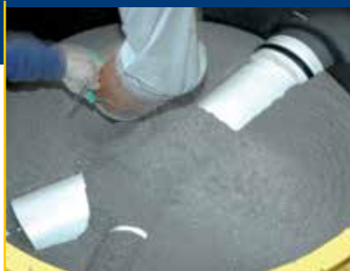
Odpowiednio dobrana mieszanka betonowa zostaje wlana w formę
